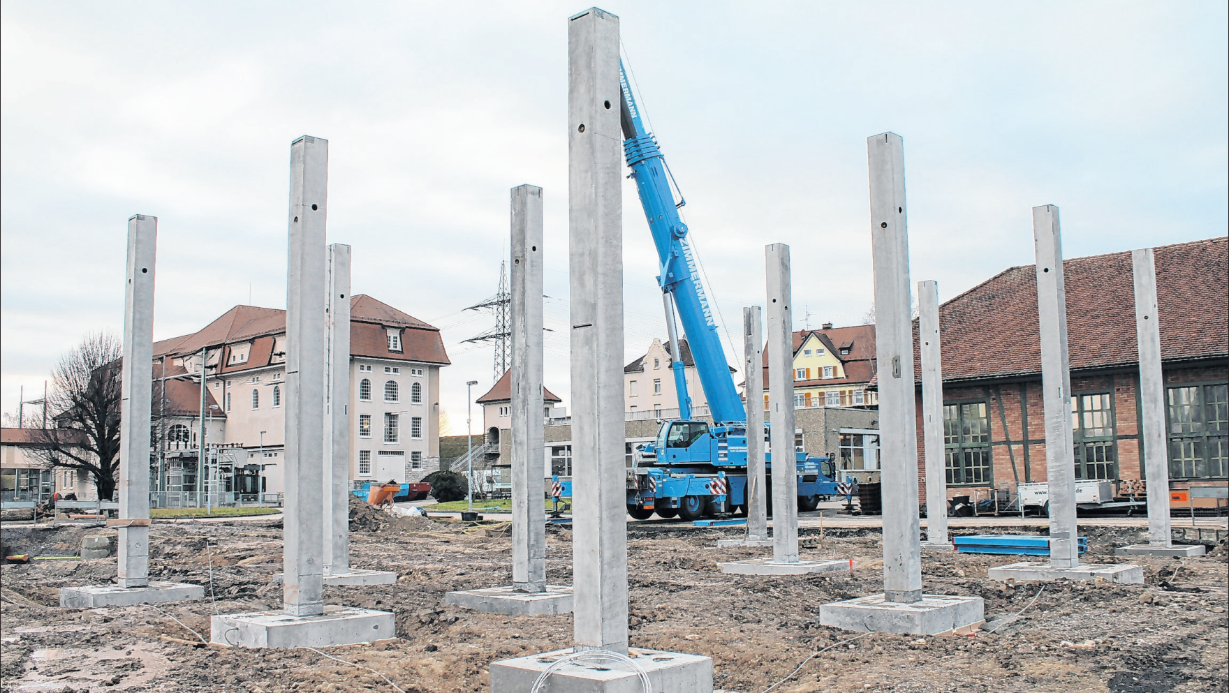
Die ersten Betonsäulen für die geplante Wasserstoff-Elektrolyseanlage sind am Dienstag errichtet worden.
